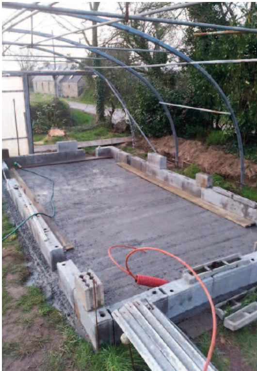
Fondation dalle béton
