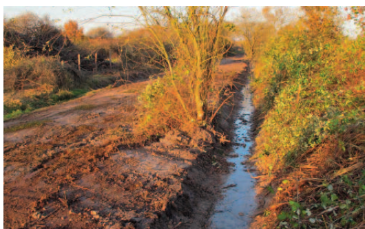
Figure 28 : entretien d'un fossé par curage sur la Réserve de Chérine, Source : RNN Chérine.
