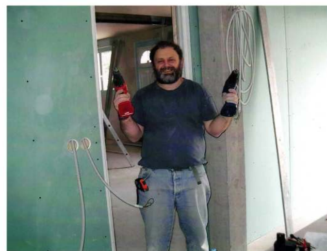
Figure 15. En 2008, Thierry Frétey, armé de deux visseuses, poursuit l'aménagement intérieur de sa maison de Saint-Maugan (Ille-et-Vilaine). Photo Mathilde Frétey.
